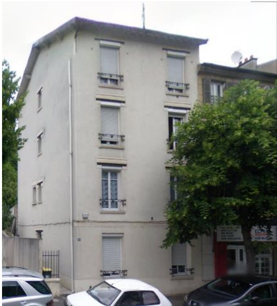
Parcelle AD n°30 et n°32 Bâtiment R+3 avec combles. Fonction résidentielle.
