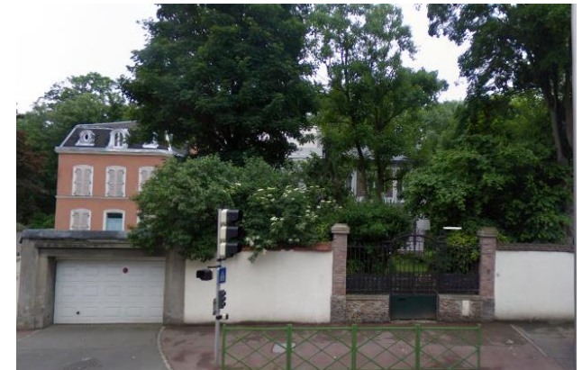
Parcelle AD n°144, n° 438 et n°440 144 : Maison individuelle R+1 avec combles. Equipement public. 438: Maison individuelle R+1 avec combles. Fonction résidentielle. En retrait par rapport à l'alignement, cette zone est classée EVP.
