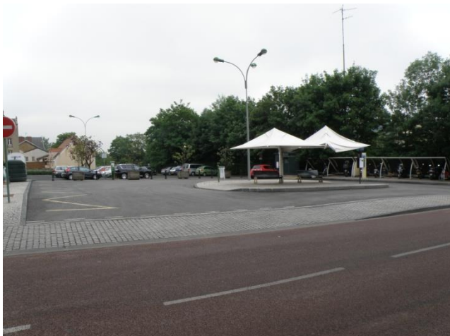
Vue sur le parking: un aménagement quasi inexistant dépréciant le lieu
