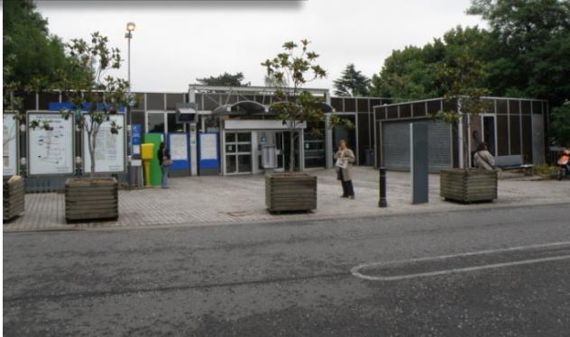
Vue sur l'entrée de la Gare Rive droite
