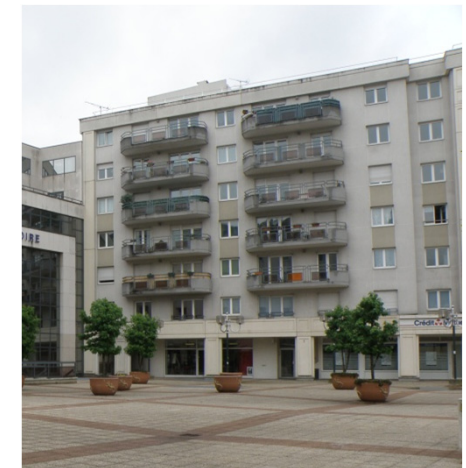
Immeuble d'habitation jouxtant l'Atrium
